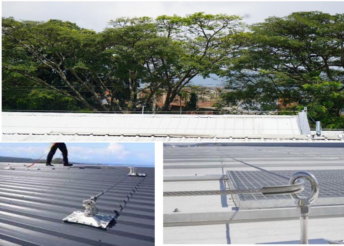
Con una inversión por un valor de \$174.909.648 se realizó la construcción y montaje de sistemas de línea de vida horizontales fijas para trabajos en alturas sobre los techos del hospital en su fase II con características técnicas y funcionales de última tecnología que permiten asegurar al máximo dos
